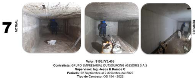
FIGURA 49. Comparación antes y después actividades adecuación y modernización de la infraestructura física, caso 7
