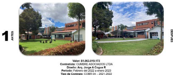
FIGURA 43. Comparación antes y después actividades adecuación y modernización de la infraestructura física, caso 1
