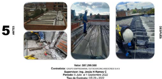
FIGURA 47. Comparación antes y después actividades adecuación y modernización de la infraestructura física, caso 5
