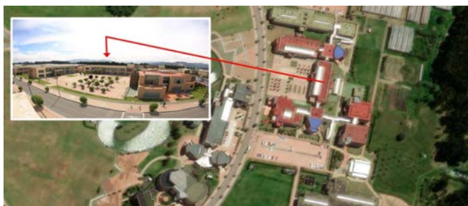
FIGURA 104. Instalación de 100 puntos de anclaje fijos en el edificio Mutis, por la empresa HSE GROUP (Resolución 4272 de 2021)
