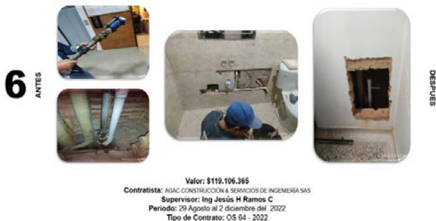
FIGURA 48. Comparación antes y después actividades adecuación y modernización de la infraestructura física, caso 6
