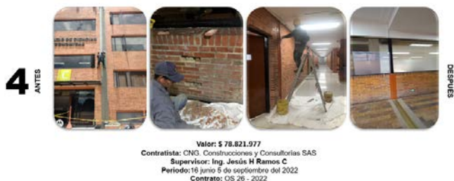
FIGURA 46. Comparación antes y después actividades adecuación y modernización de la infraestructura física, caso 4
